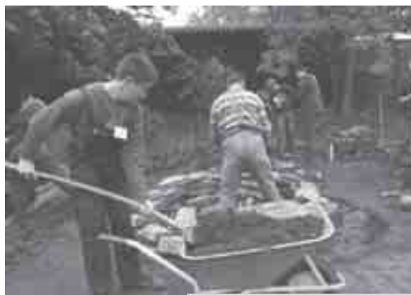
Bau der Kräuterschnecke
